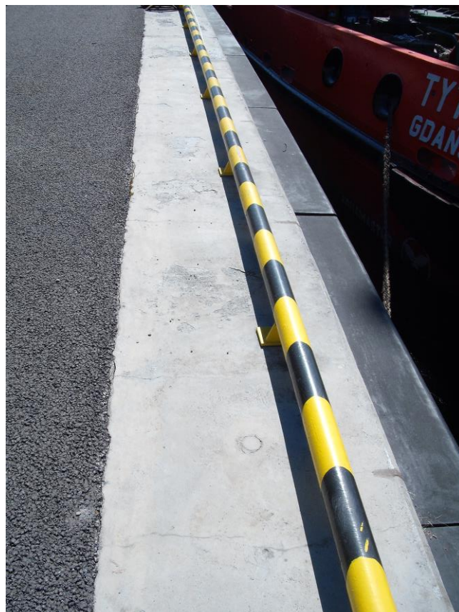
Fot. 6. Złuszczenia powierzchni betonu w koronie ściany odwodnej nabrzeża.
