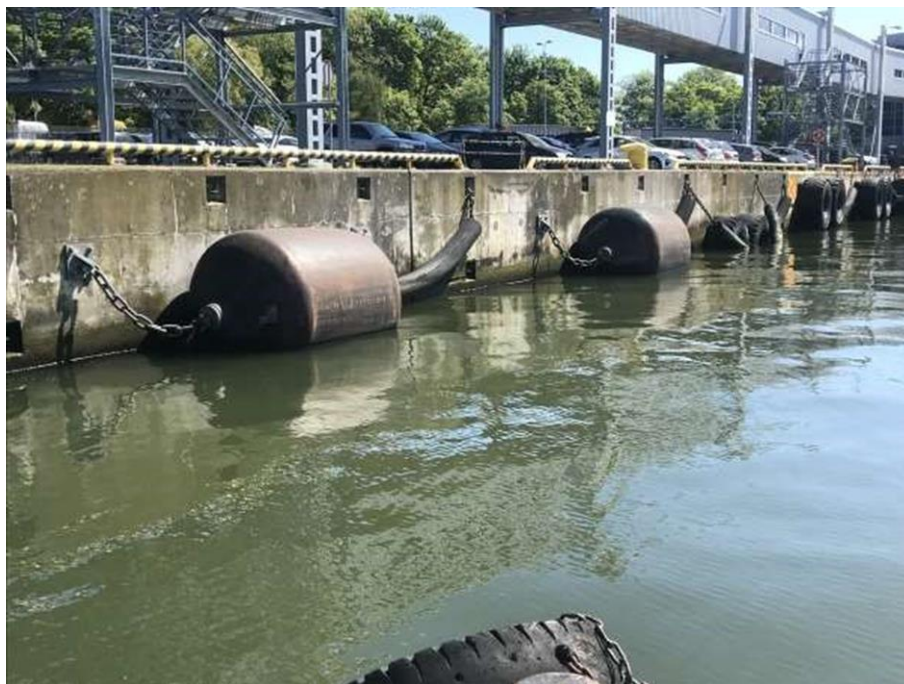
Fot. 21. Widok punktowej odbojnicy pneumatycznej mocowanej łańcuchami do ściany odwodnej nabrzeża
