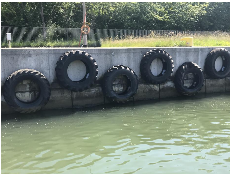
Fot. 2. Ściana czołowa (odwodna) nadbudowy nabrzeża z ochronnymi oponami staroużytecznymi
