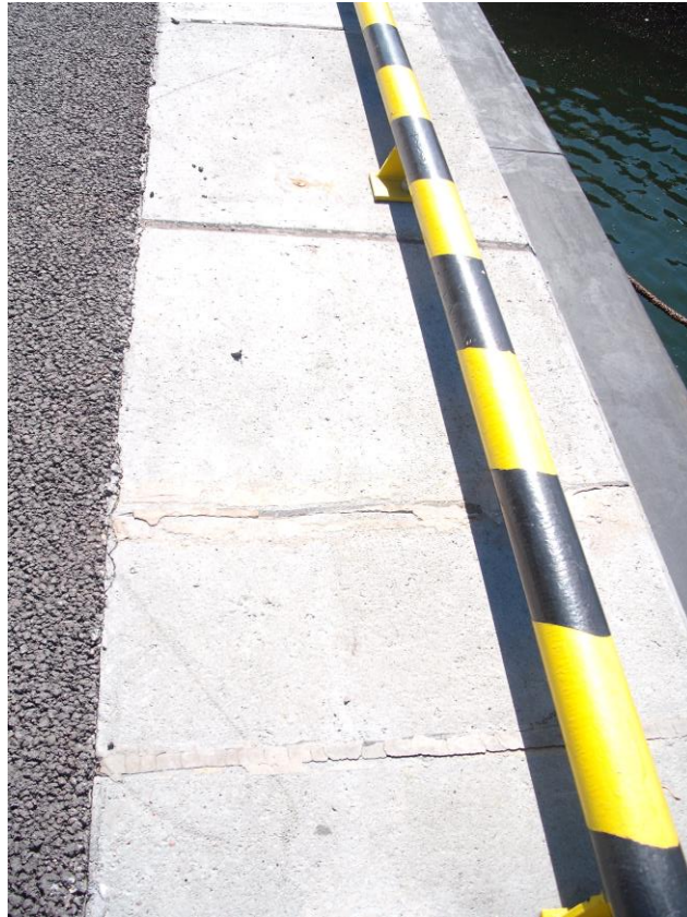
Fot. 5. Widoczne zarysowania (z odpajającym się uszczelnieniem) w nadbudowie nabrzeża.
