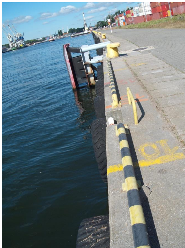
Fot. 19. Widok fragmentu naziomu nabrzeża (nawierzchnia z kostki betonowej); widoczna odbojnica punktowa z dodatkową wyrównawczą konstrukcją wsporczą
