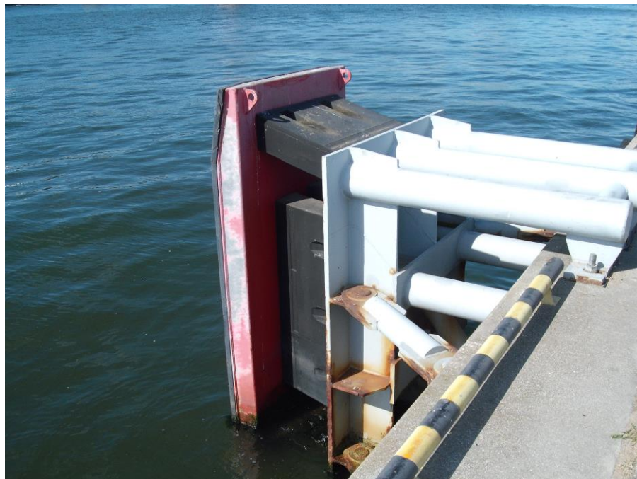
Fot. 18. Punktowe urządzenie odbojowe na ścianie odwodnej nabrzeża
