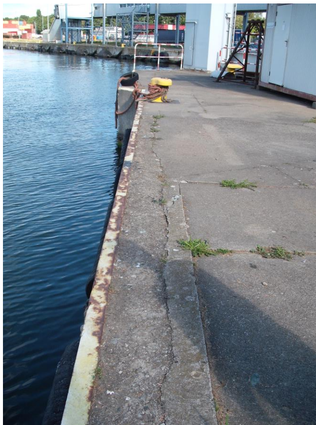
Fot. 27. Fragment naziomu nabrzeża (widoczna korozja kątownika ochronnego)
