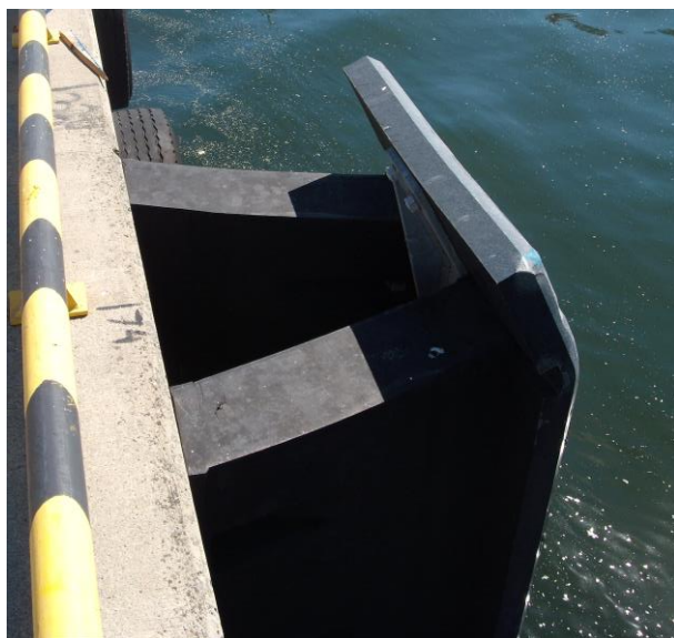
Fot. 13. Uszkodzona gumowa „noga” odbojnicy punktowej (w pobliżu pachoła nr 53)
