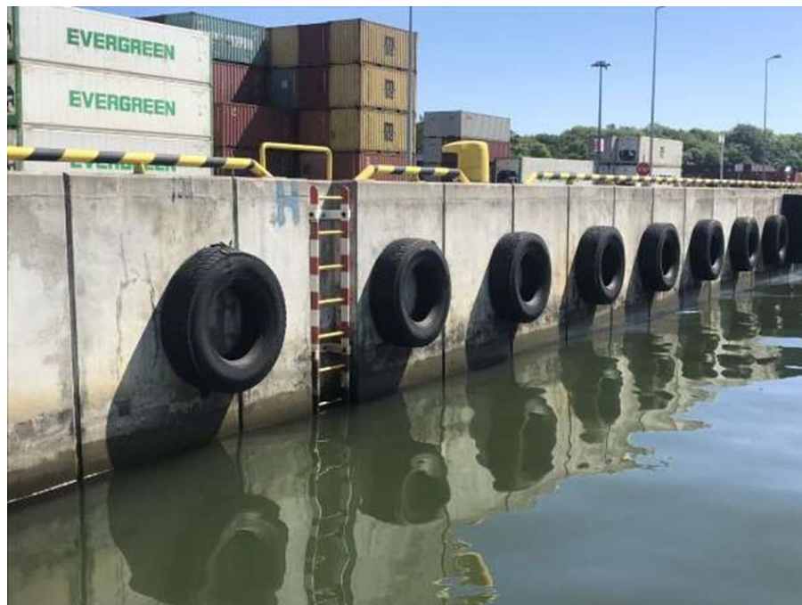
Fot. 16. Widok odwodnej ściany nabrzeża z odbojnicami z opon staroużytecznych.
