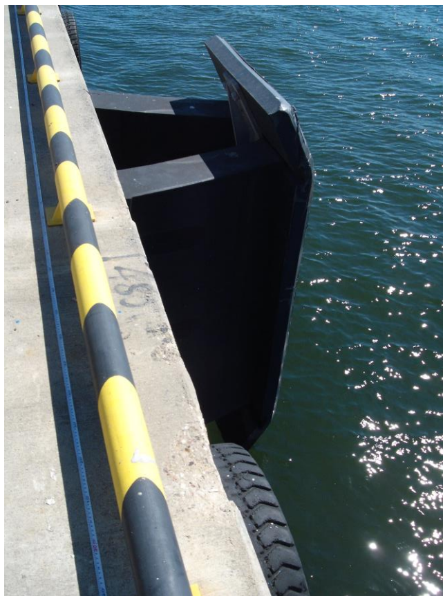
Fot. 12. Fragment górnej części ściany odwodnej nabrzeża z niewielkimi wykruszeniami betonu
