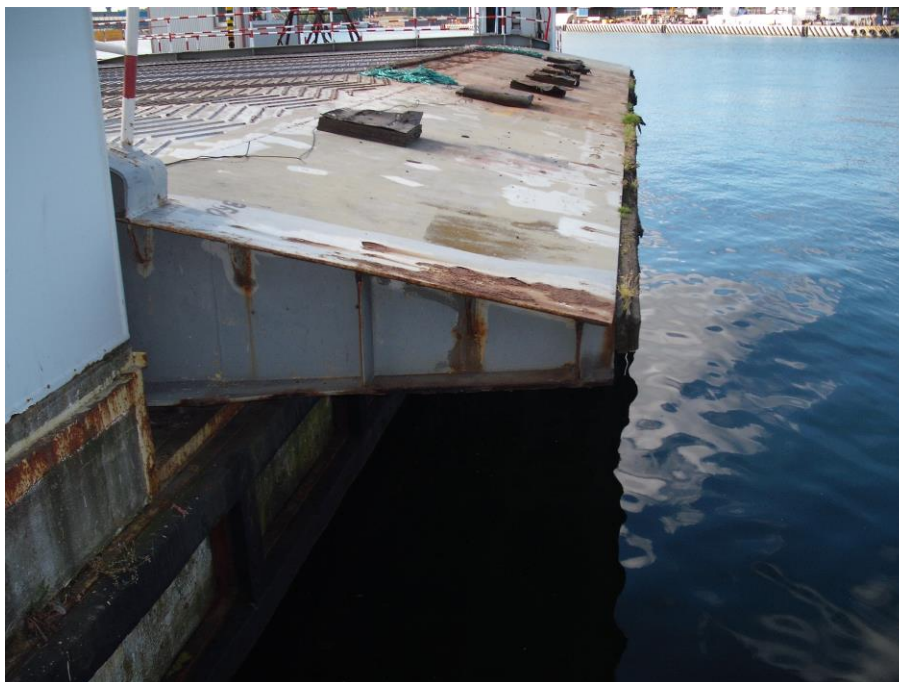
Fot. 26. Widok konstrukcji czołowej części rampy z powierzchniową korozją
