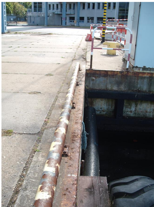
Fot. 23. Naziom nabrzeża – skorodowanie elementów wyposażenia
