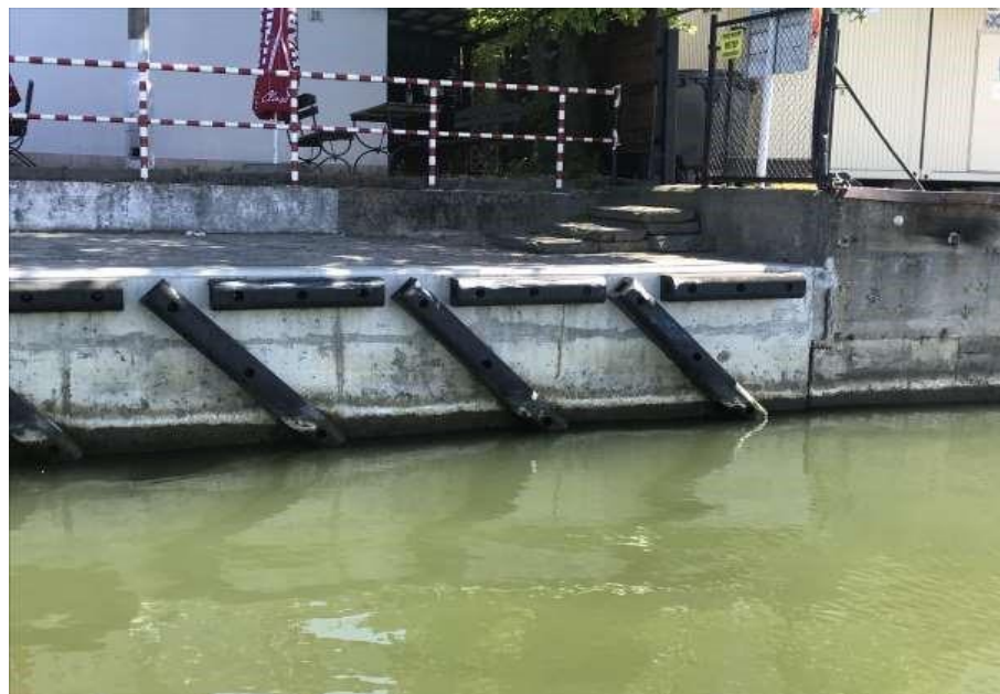
Fot. 31. Widok ściany odwodnej nabrzeża z belkami odbojowymi
