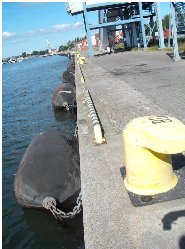
Fot. 20. Widok fragmentu naziomu nabrzeża (nawierzchnia z kostki betonowej)
