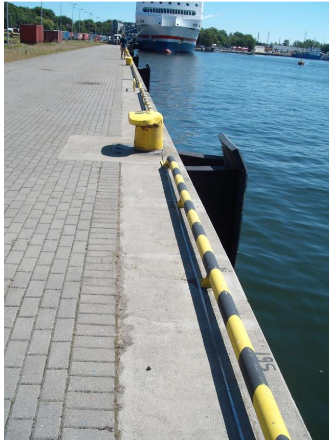
Fot. 15. Naziom nabrzeża z nawierzchnią z kostki betonowej
